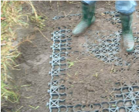
Figuur 17: vullen van roosters met zand
