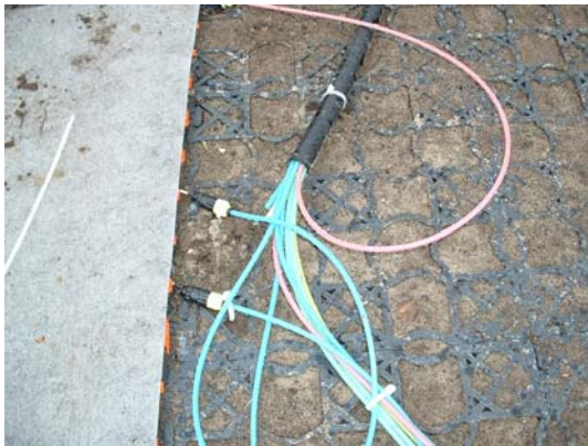
Figuur 32: afwerking van sensorkabel
