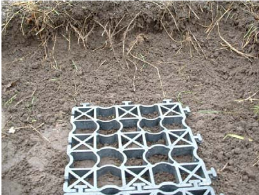
Figuur 15: leggen van de roosters
