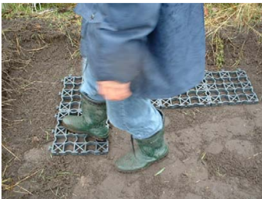
Figuur 16: aandrukken van de roosters
